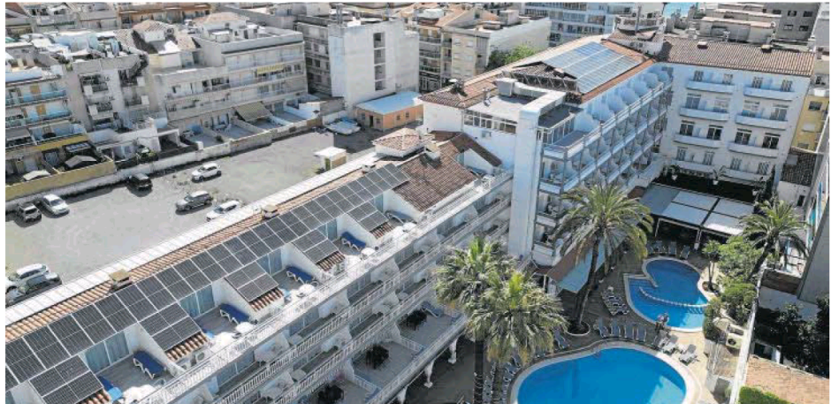
Les plaques fotovoltaïques de Solimar proveeixen el 60% del consum energètic del complex en temporada alta. FOTO: CEDIDA
